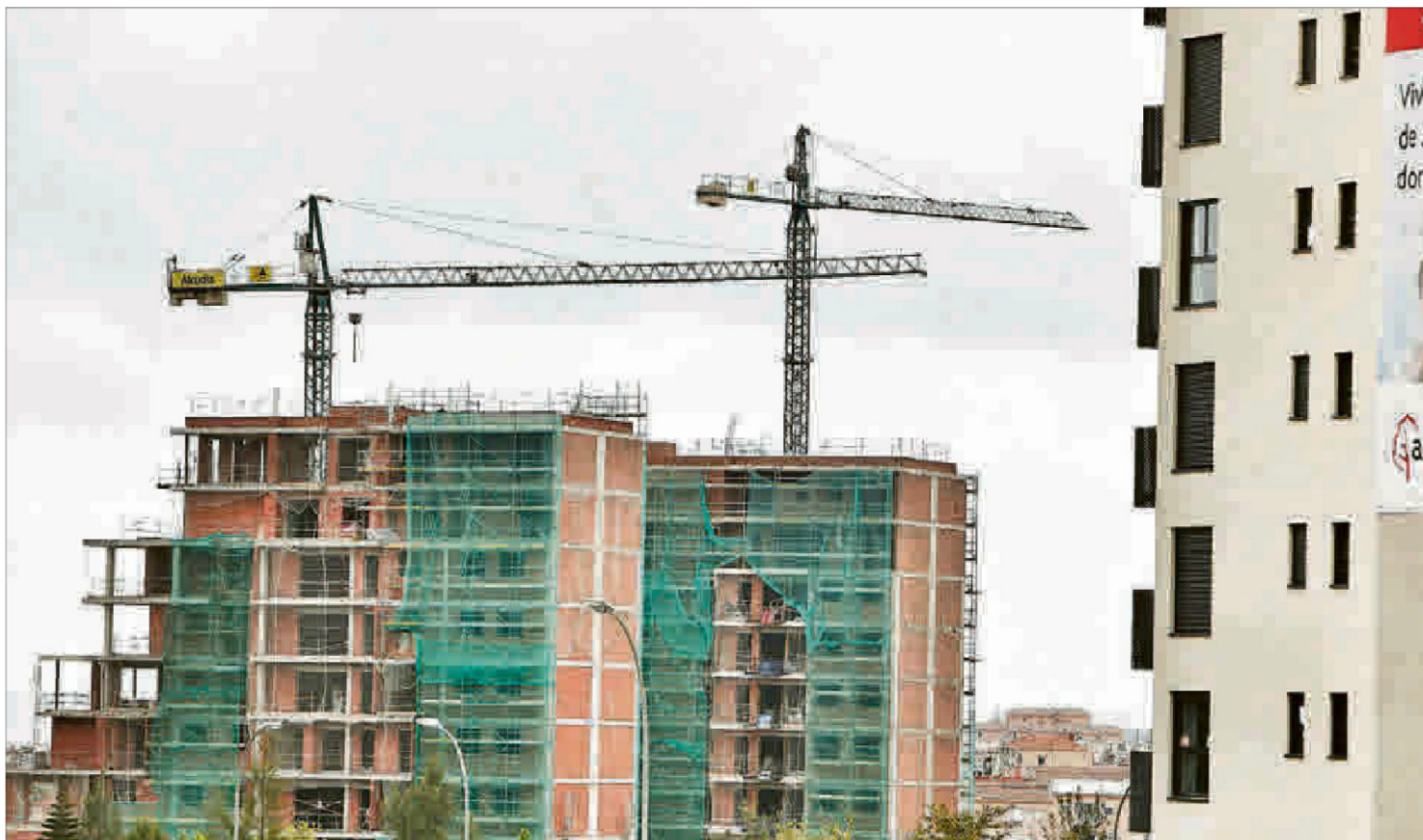
Un grupo de edificios en construcción en la ciudad de Alicante. RAFA ARJONES
